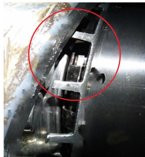
轴承保持架断裂
